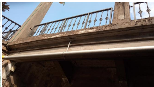
-chránička, trhliny na římse
