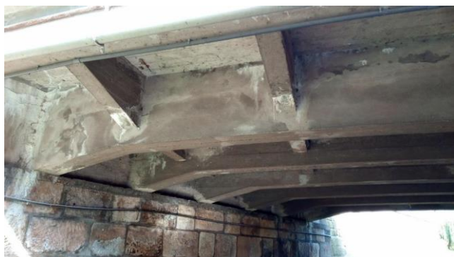
-Masivní průsaky přes NK
