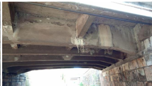
-Masivní průsaky přes NK, krápníky
