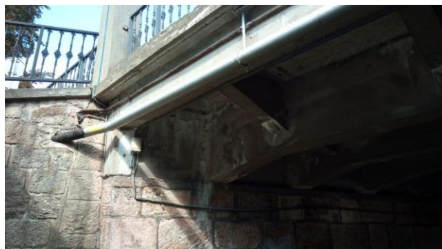
-Zatékání na krajní trám
